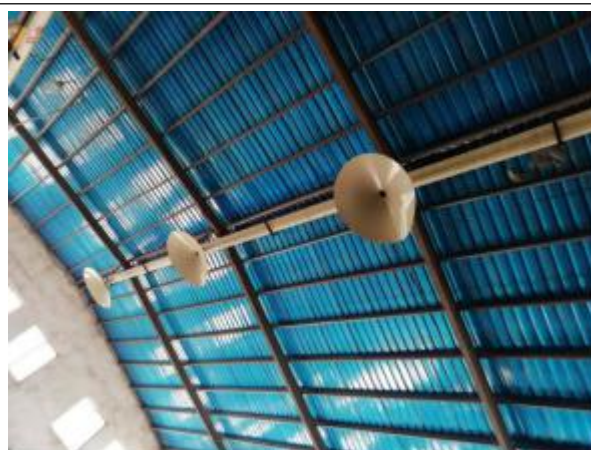
氯代醚酮车间废气收集设施
