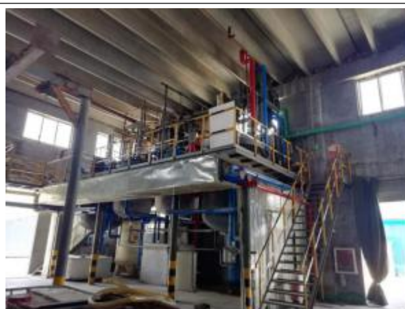
三嗪车间反应釜（西北侧）
