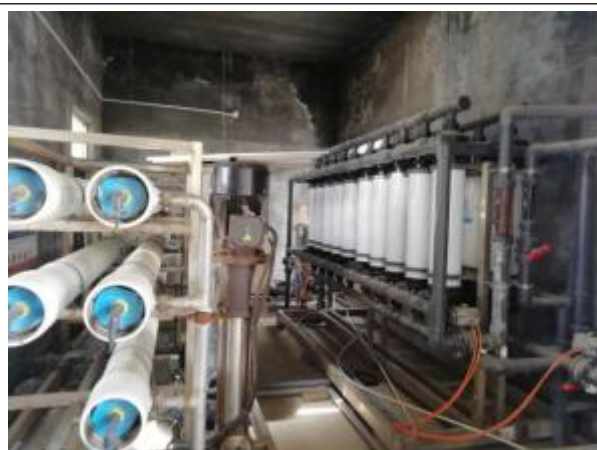
水处理反渗透装置
