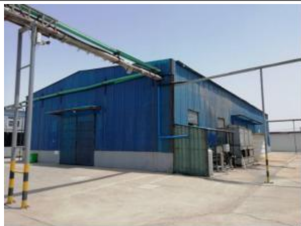
空桶仓库及冷冻机房
