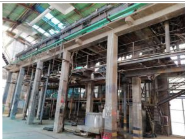
硫酰氯车间反应釜（西北侧）
