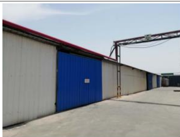
三嗪车间中间体存放区
