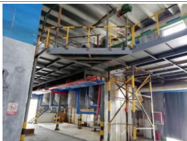
三嗪车间反应釜（东南侧）
